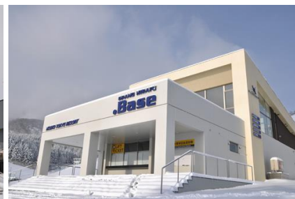
2012年 .Base(ドットベース)新設
